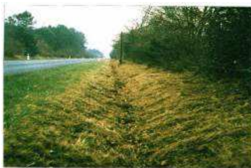
Fig. 9. Exemple de noue. Source : SETRA
